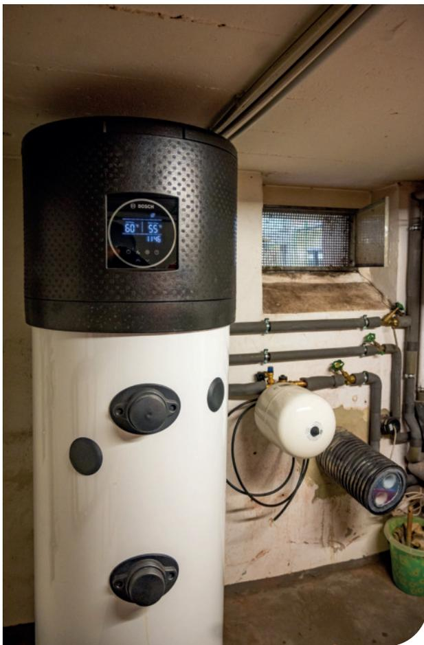
**Die neue Wärmepumpe sichert die Warmwasserversorgung der Mieter über die Heizungsabwärme. Hierfür wird zukünftig nur noch ein Viertel der bisherigen Energie benötigt.**
